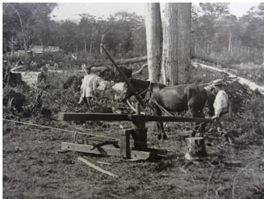
図1.「抜根機ニテ抜根ノ景」
