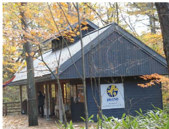
図 11 星野温泉敷地内ピッキオの事務所
